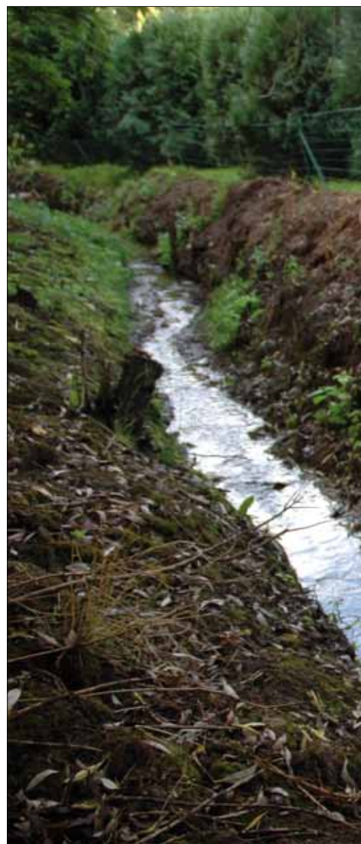
La dégradation des berges d'
